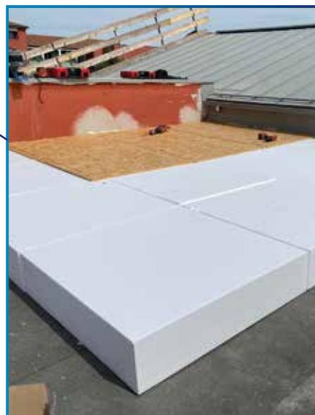
Figura 1 - Disposizione pannelli termoisolanti pendenzati in copertura (scala 1:50)
